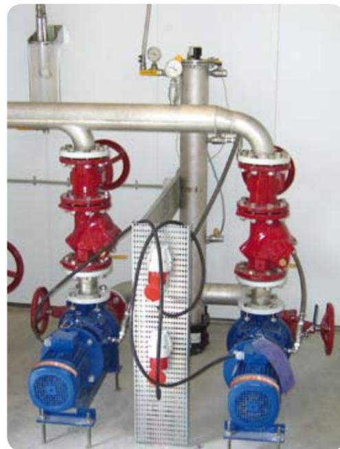
Pumpstekniks automatiska vakuumsystem kopplat till torrappställda avloppspumpar, typ Hidrostal.
